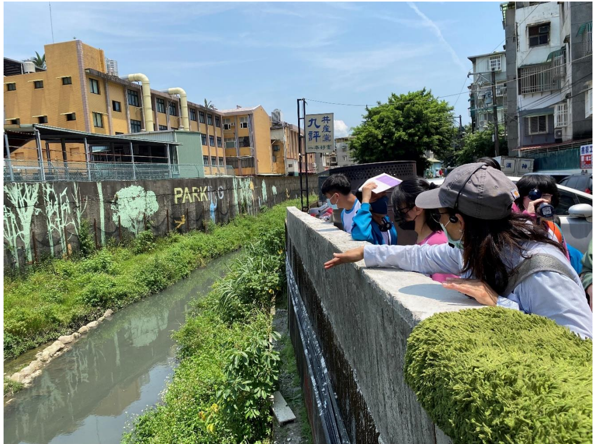
照片 4-子母溝的渠道工法增加流水速度；河道兩旁植栽綠化，營造友善生態的棲地環境
